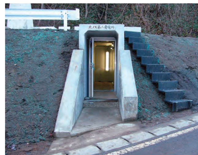
北ノ又第三発電所（入口）
