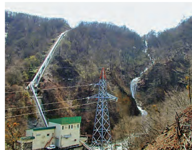
北ノ又発電所
