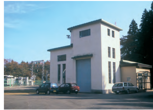
胆沢第二発電所
