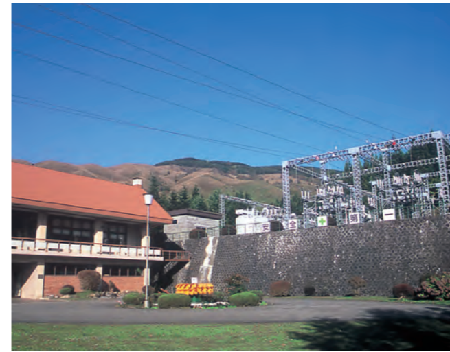
岩洞第一発電所
