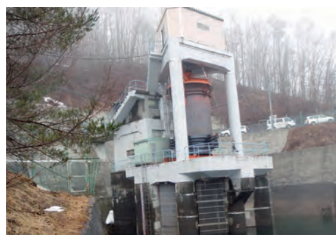
【写真】岩洞取水口
