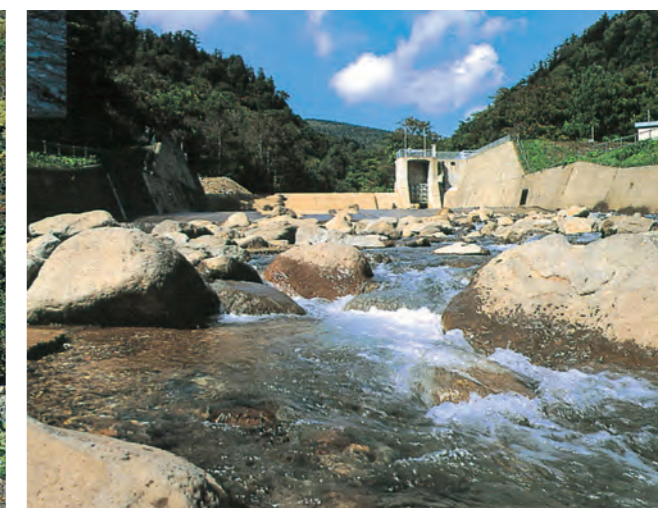
北ノ又川第二取水堰堤
