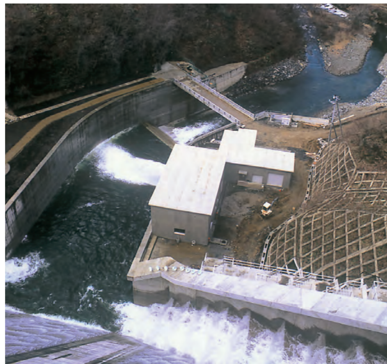
早池峰発電所
