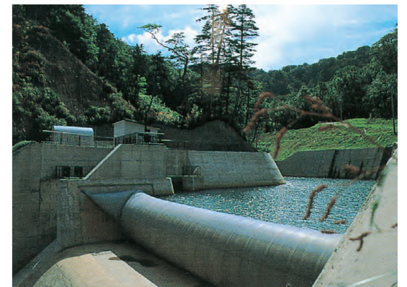
松川取水堰・ゴム引布製起伏堰
