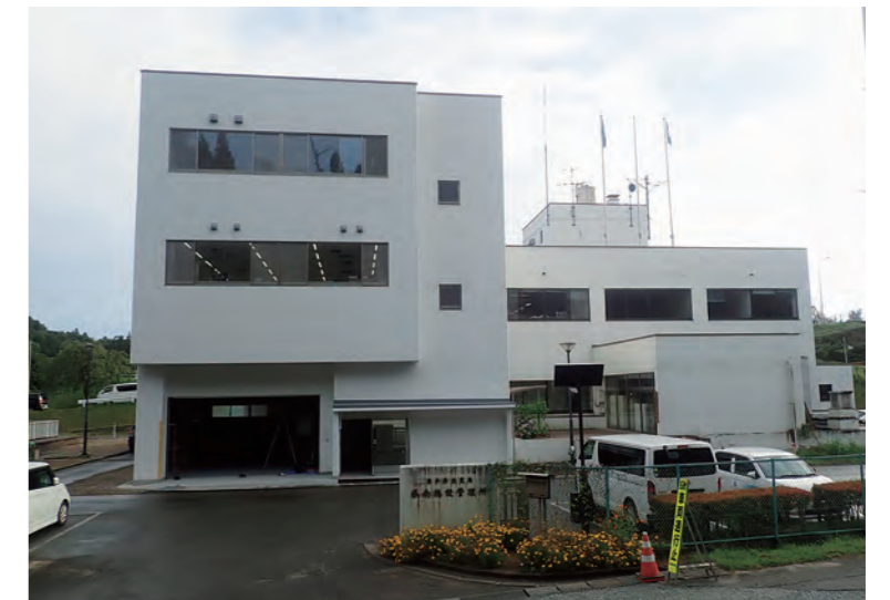
県南施設管理所
