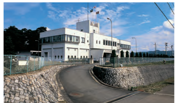
第一浄水場 (旧北上工水) 管理棟
