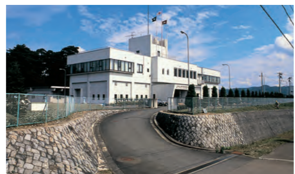
第一浄水場 (旧北上工水) 管理棟
