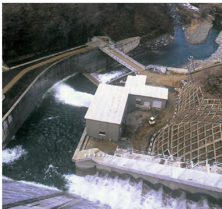
早池峰発電所
