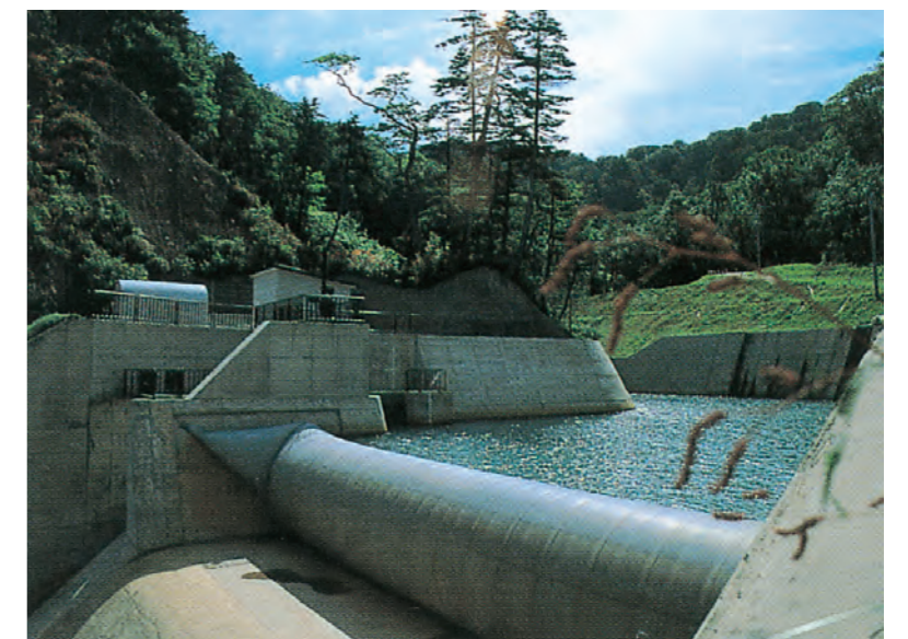
松川取水堰・ゴム引布製起伏堰
