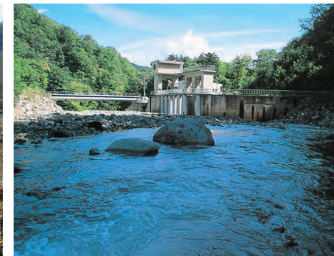
北ノ又川取水堰堤
