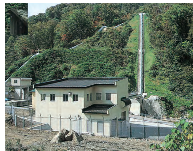
北ノ又第二発電所
