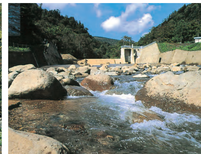
北ノ又川第二取水堰堤
