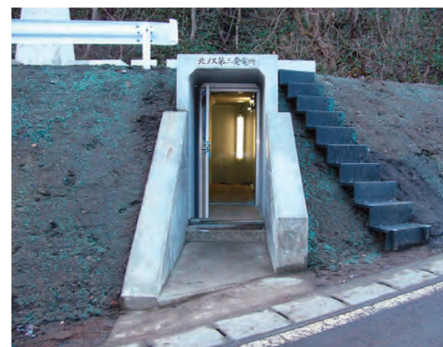
北ノ又第三発電所（入口）
