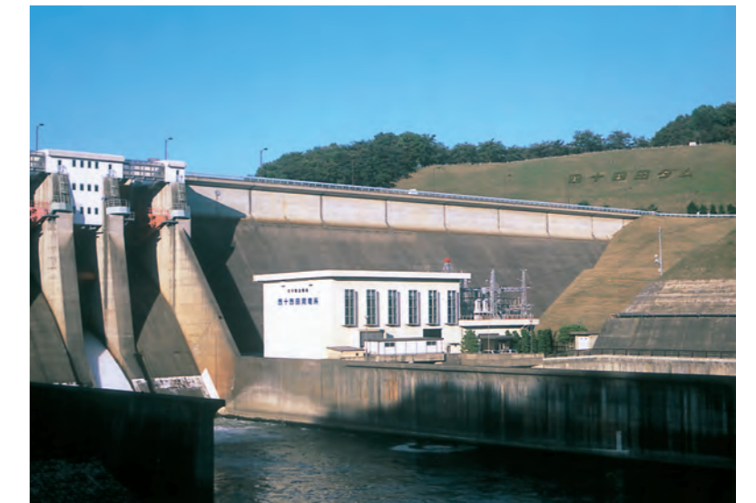
四十四田発電所
