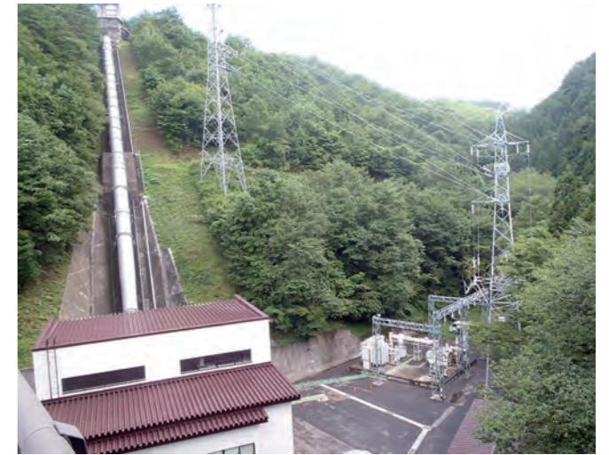
岩洞第二発電所
