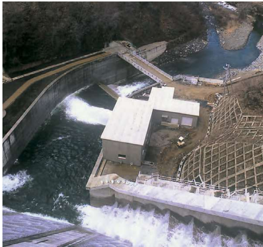
早池峰発電所
