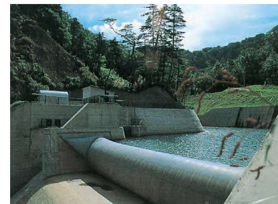
松川取水堰・ゴム引布製起伏堰
