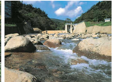
北ノ又川第二取水堰堤
