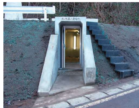
北ノ又第三発電所（入口）
