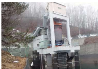
【写真】岩洞取水口
