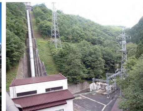
岩洞第二発電所
