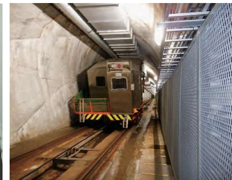
インクライン (地下発電所と地上を結ぶケーブルカー)
