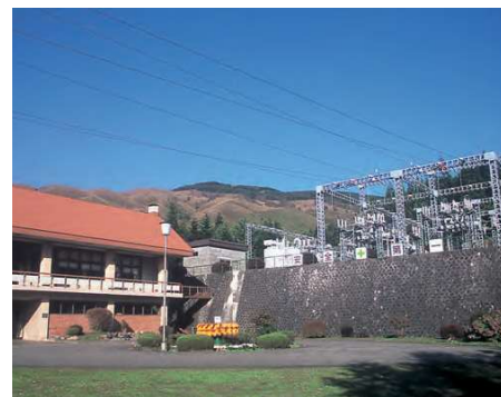
岩洞第一発電所
