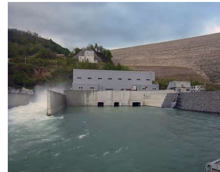
胆沢第三発電所
