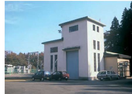
胆沢第二発電所
