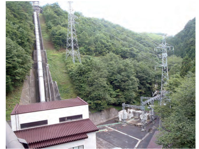
岩洞第二発電所
