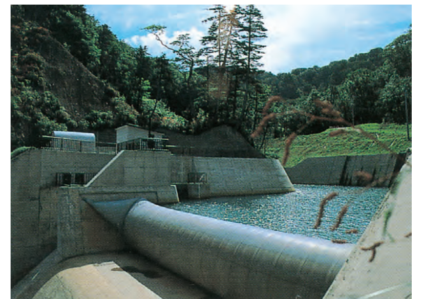
松川取水堰・ゴム引布製起伏堰
