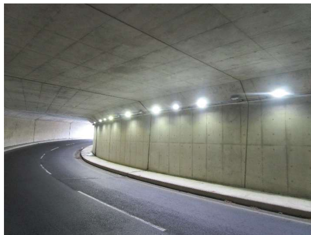
小佐原1号線道路照明のLED化（宮古市）
