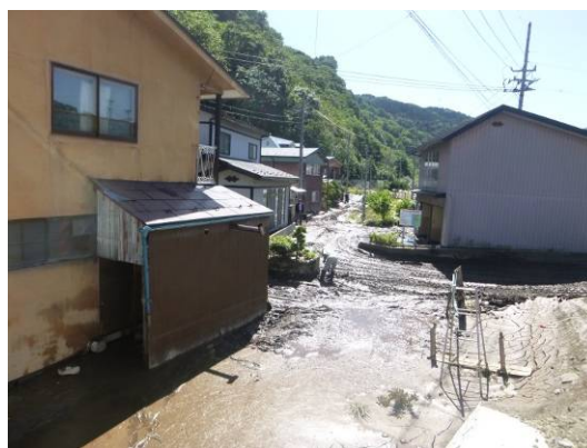
馬淵川 かわらばし 川原橋上流右岸(石切所地区) いしきりどころ
