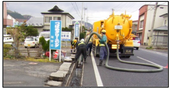
側溝清掃作業
