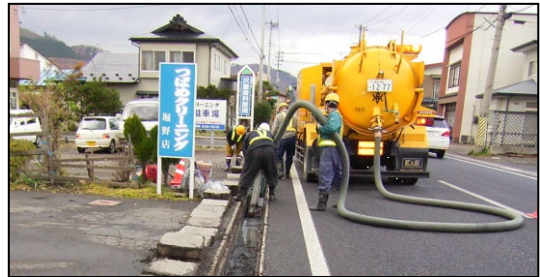
側溝清掃作業
