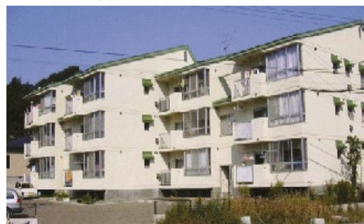
県営北福岡団地(二戸市)
