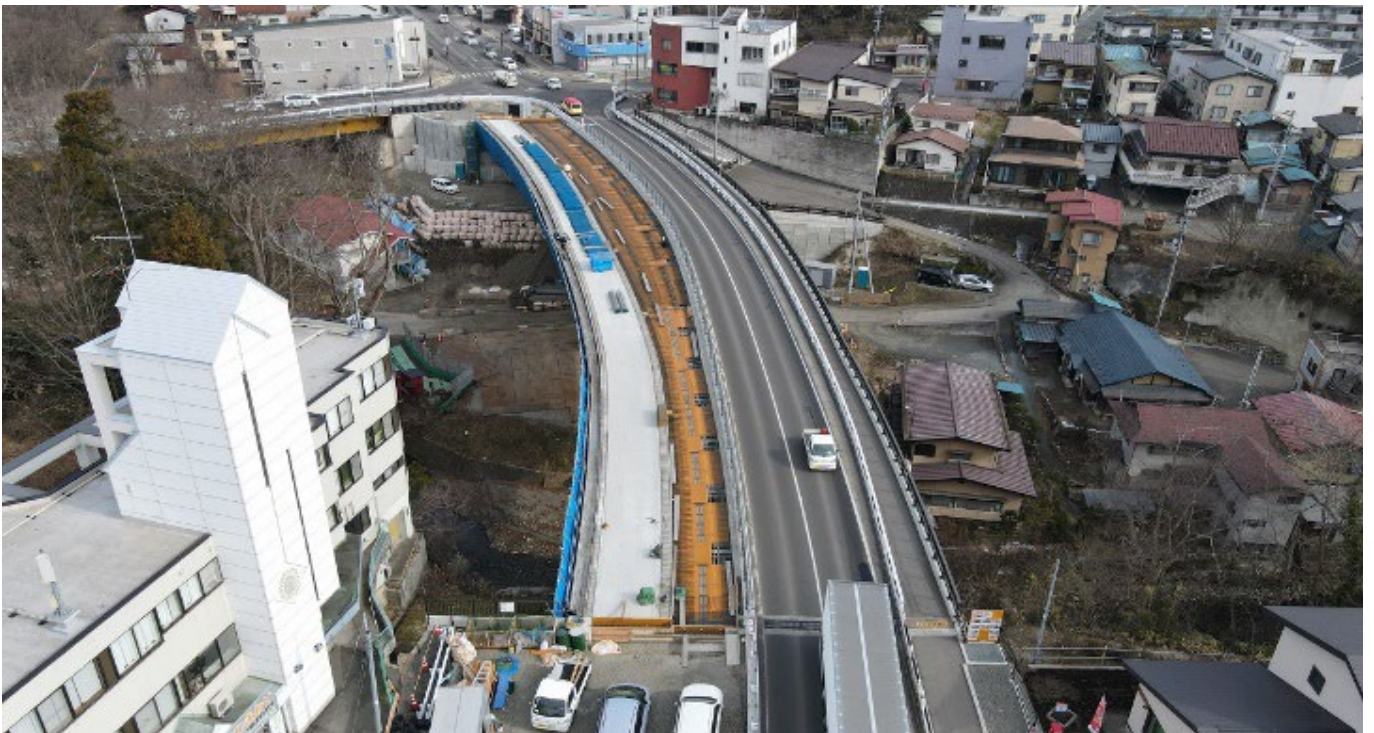
都市計画道路荒瀬上田面線（岩谷橋）の施工状況
