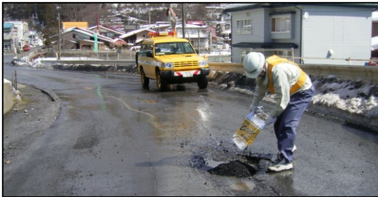
パトロールによる穴埋め作業
