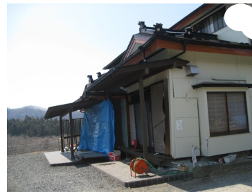
H23. 3. 11 東日本大震災津波による住宅の被害状況
