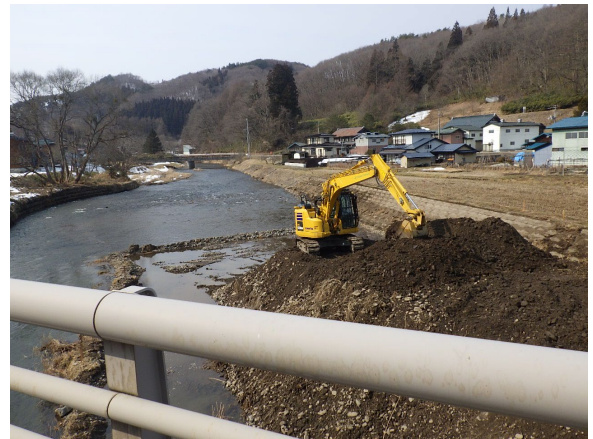
河道断面維持のための掘削作業
