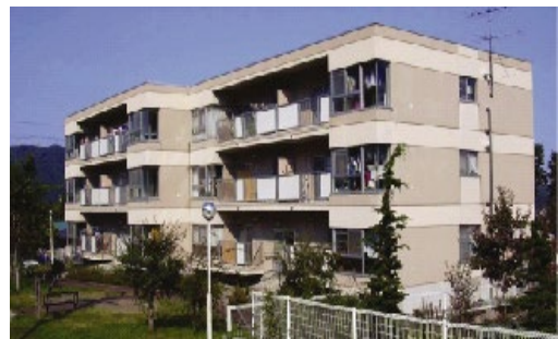
県営石切所団地(二戸市)
