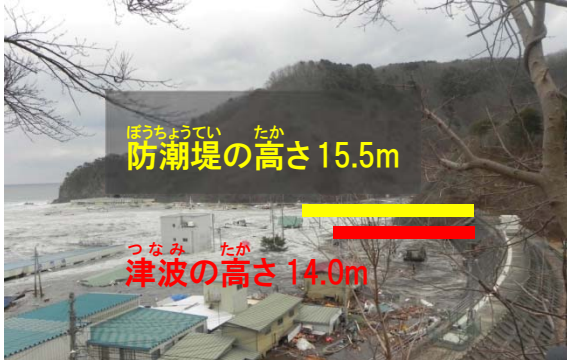
太田名部防潮堤（昭和42年建設）
