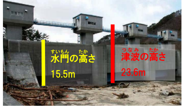
普代水門（昭和59年建設）
