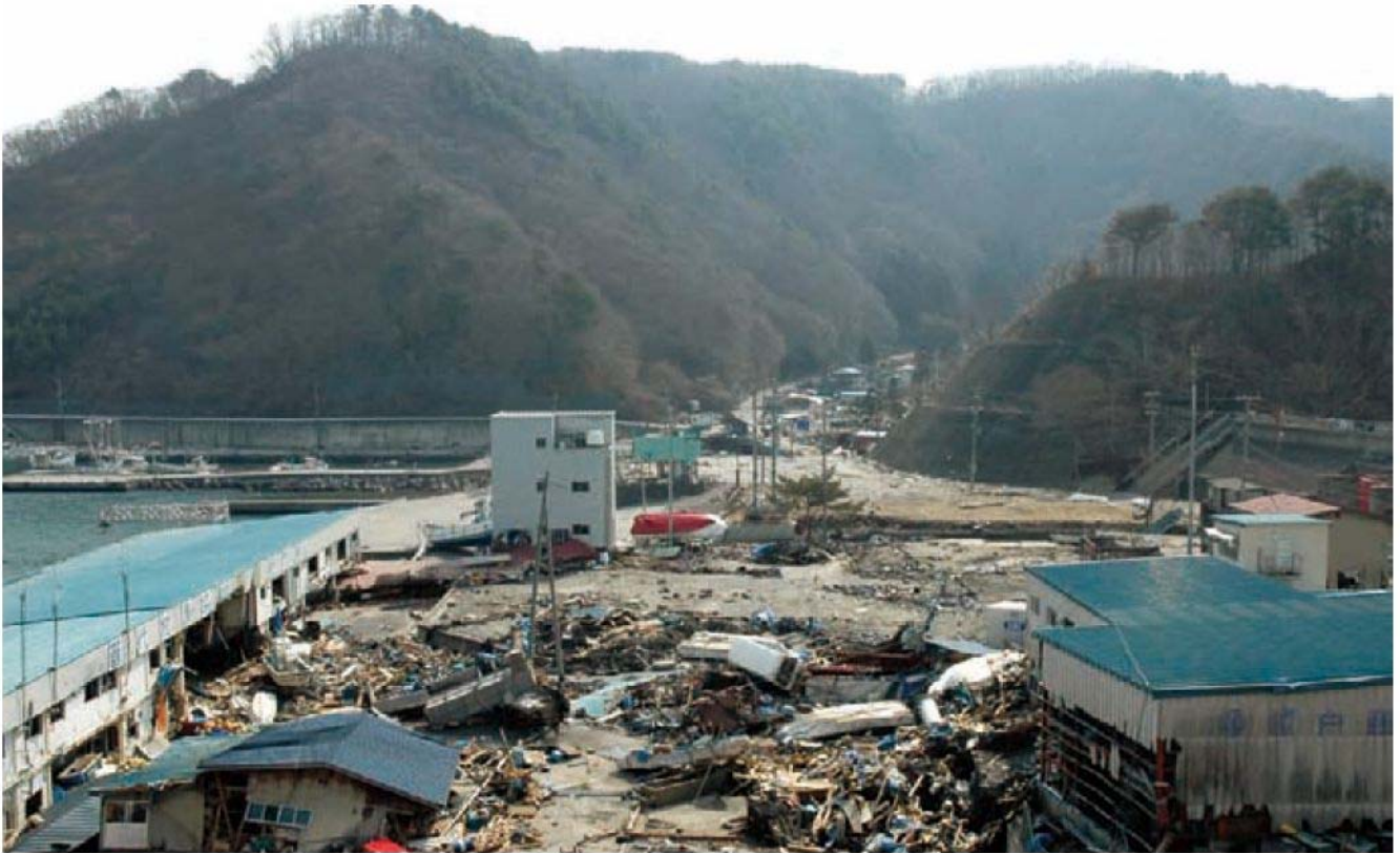
太田名部漁港は壊滅的な被害を受けたが、防潮堤の内側に浸水することはなかった 写真提供／岩手日報社
