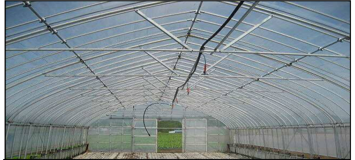
吊り上げ式マイクロスプリンクラーかん水(果樹・育苗等)
