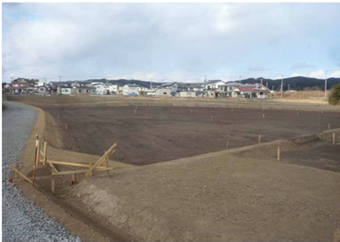
【現地の復旧後の状況】
