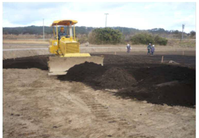
【復旧工事 (表土搬入整地)】
