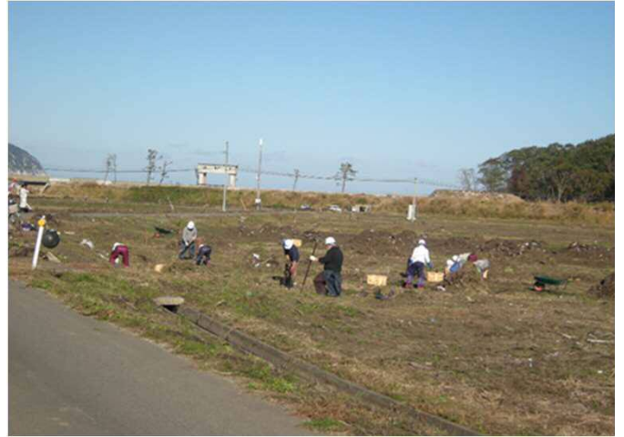
【人力によるガレキ撤去】
