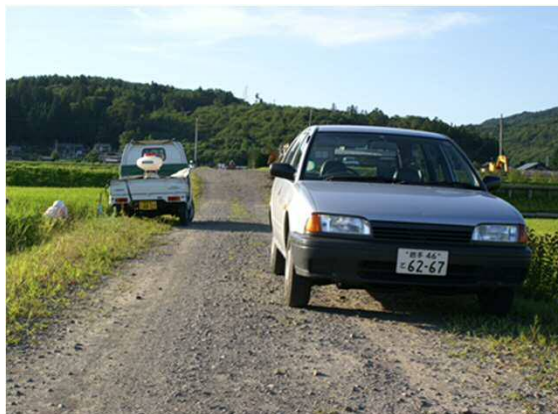
【整備後：幅員が広くすれ違いが可能】
