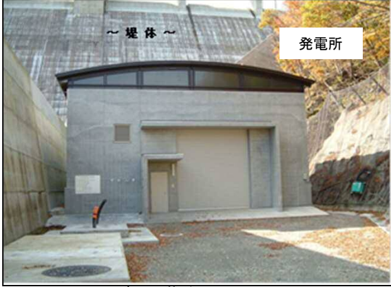
ダムの落差で発電
