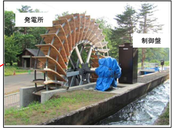
水路の水で水車を回転させ発電
