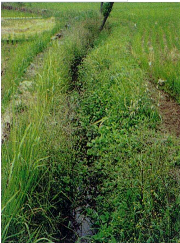
【未整備：用排兼用の土水路】
