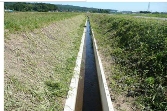
【整備済（排水路）】
