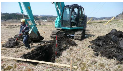
仮排水路施工
