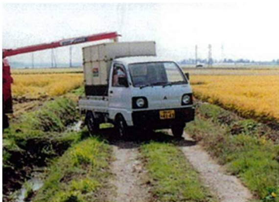
【整備前：幅員が狭い】
