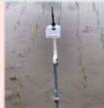
水位センサーの設置
