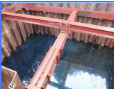
立坑釜場の現況写真
