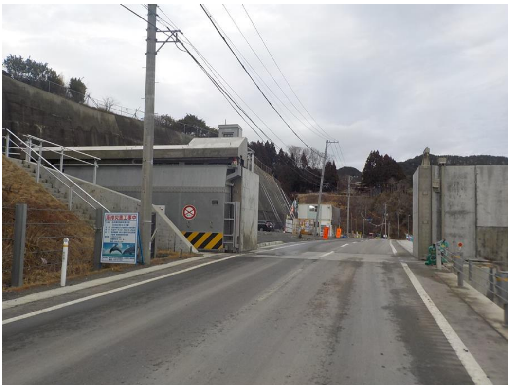
【広内海岸陸閘】
