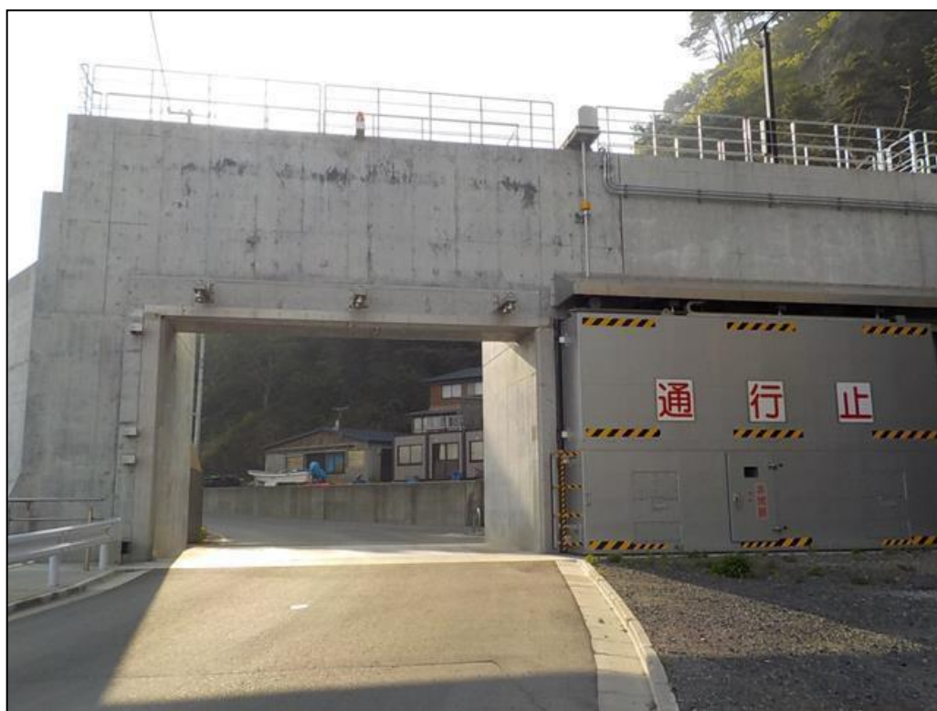
【久喜漁港海岸陸閘】
