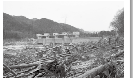
大津波から村を守った普代水門(普代村、3月20日)
