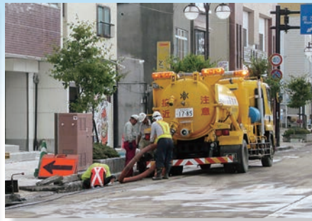
久慈駅付近での道路側溝の泥除去(9月6日)
