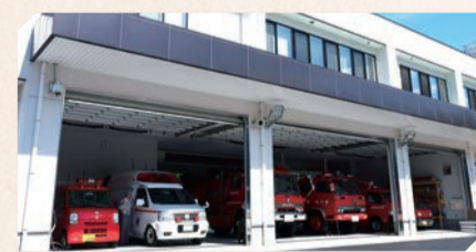
災害時には周辺住民40名ほどの避難スペースとしても活用できる
