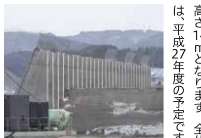
前浜地区の防潮堤(2月6日)
