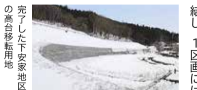
完了した下安地区の高台移転用地
