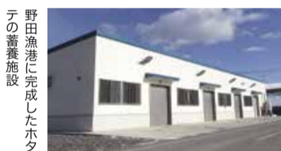
野田漁港に完成したホタテの養殖施設
