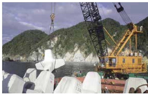
増殖場となるブロックを久喜沖に沈めている様子
