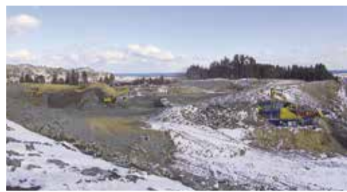
造成工事が進む城内地区の高台移転用地(2月6日)
