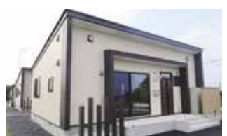
八木地区の町営災害公営住宅
