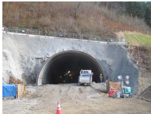
貫通から6日後の外側の様子
