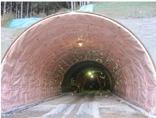
防水シートを張り終えた様子
