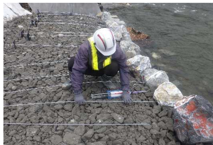
写真-4 アンカーの固定状況
