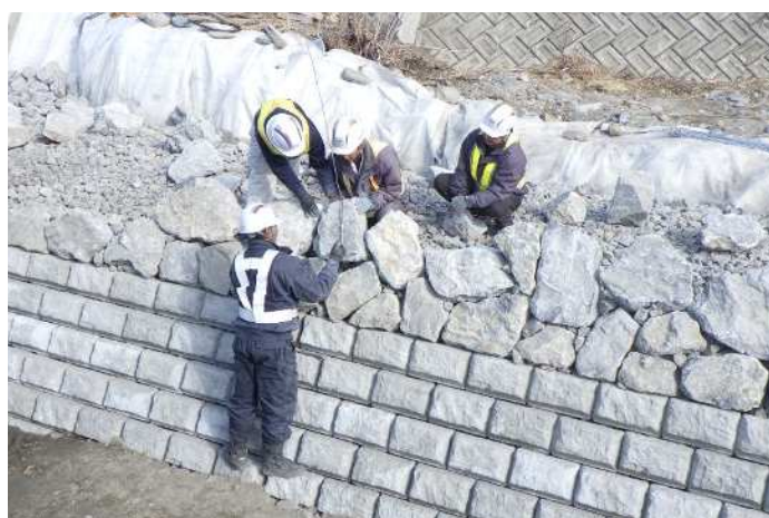
写真-3 石積み状況
