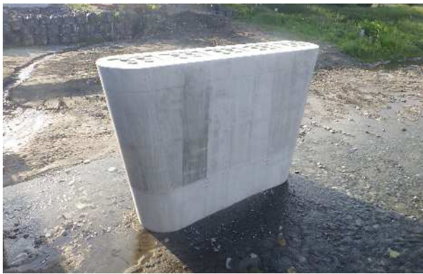
写真-1 完成した橋脚
