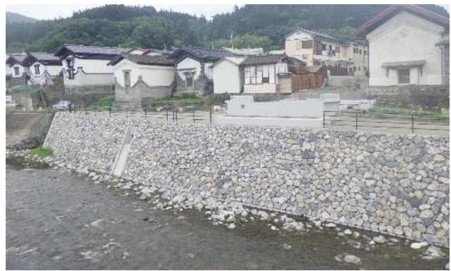
写真-2 一部完成した世田米駅地区側の護岸
