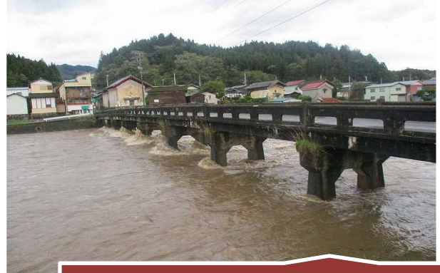
増水の状況(昭和橋)
