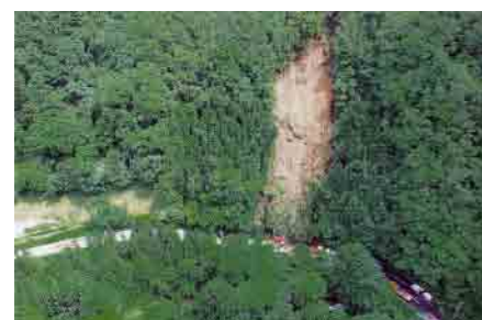
▲H15.7.10 大雨による法面崩壊
