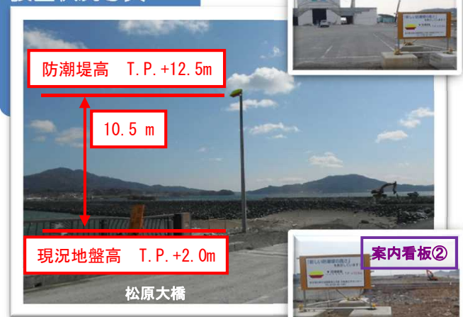
設置状況写真
