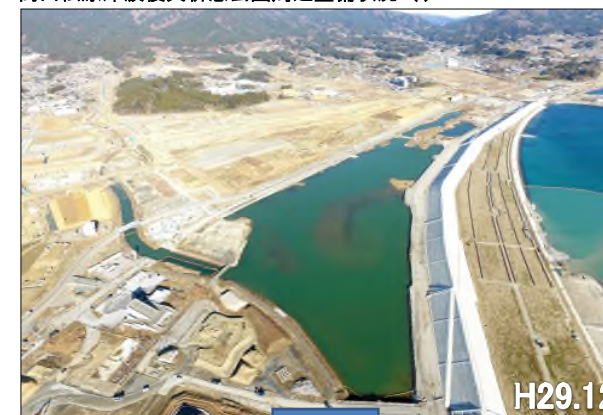
高田松原津波復興祈念公園周辺整備状況 (3)
