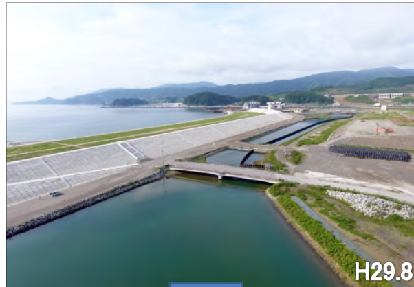
高田松原津波復興祈念公園周辺整備状況 (5)
