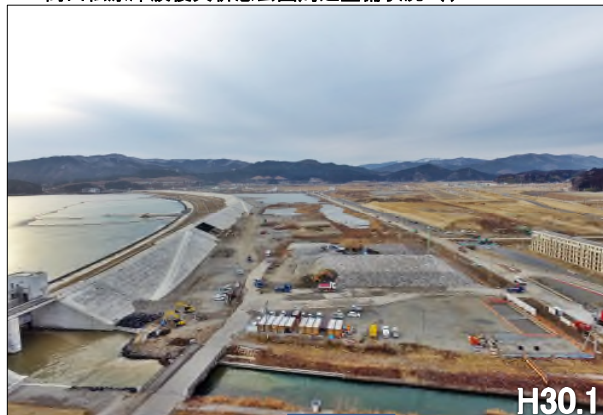
高田松原津波復興祈念公園周辺整備状況 (2)
