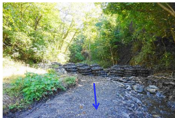
袋詰玉石工を用いた仮設土留め
