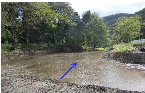
既設砂防堰堤の緊急除石
