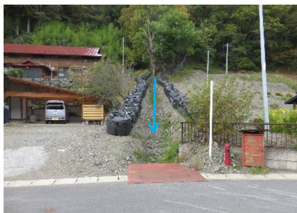
大型土のうによる仮設導流堤(2)
