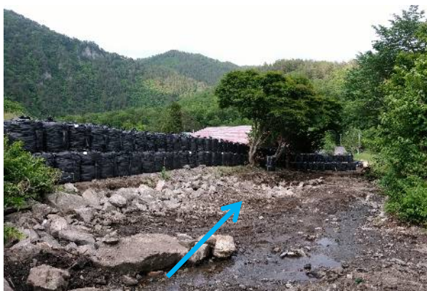
大型土のうによる仮設導流堤(1)
