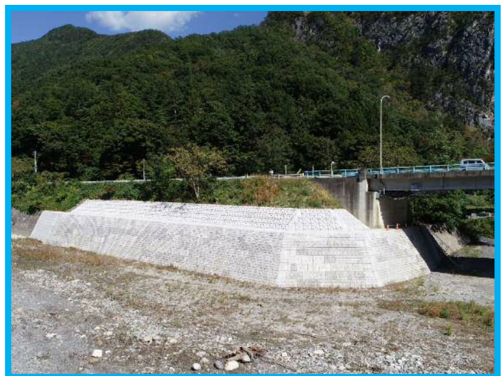
復旧工事完成状況(H30.10)
