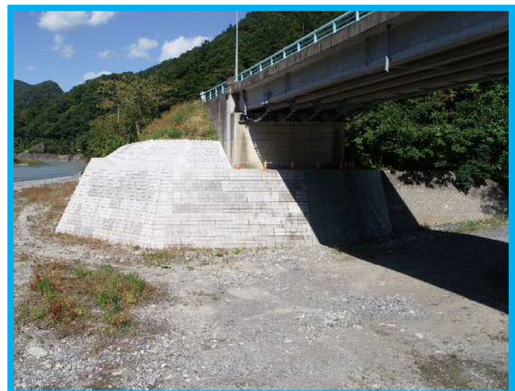
復旧工事完成状況(H30.10)
