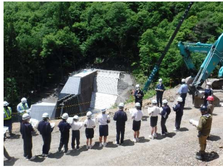
工事中の砂防堰堤を見学 (松橋川筋滝野地区砂防堰堤工事)
