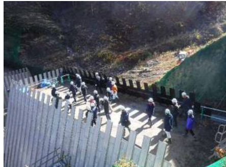
工事中の砂防堰堤の上に登ってみた！ (南三田貝の沢(2)砂防堰堤工事)
