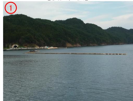
(防波堤:倒壊、沈下、消波工飛散)
