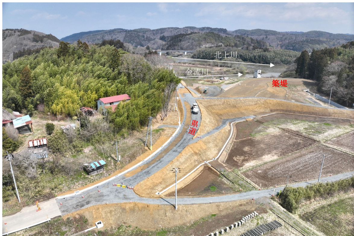
一級河川金流川永井地区 築堤及び県道嵩上げ工事の施工状況
