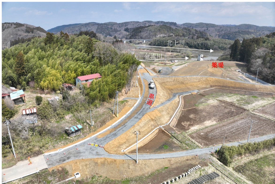
一級河川金流川永井地区 築堤及び県道嵩上げ工事の施工状況
