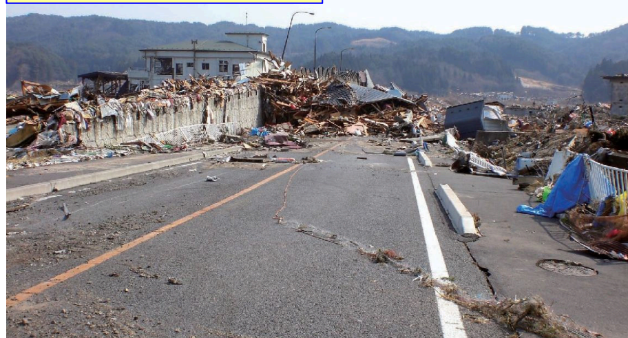
被災状況(H23.3.12)
