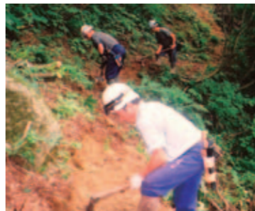
新ルート開削作業
