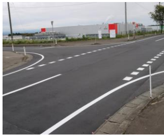
市道舗装工事
