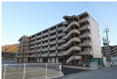
災害公営住宅新築工事
