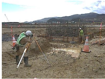
農地災害復旧事業工事
