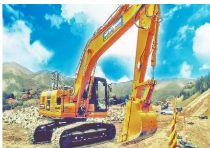
三陸復興道路 工事現場
