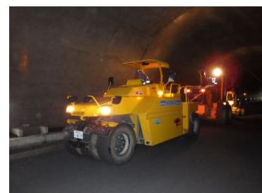
トンネル内での舗装
