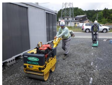
小型重機を使用した舗装
