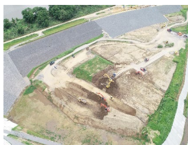
ドローンからの現場画像 (一関第3遊水地)
