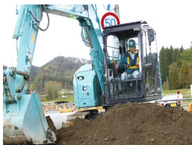
バックホーでの掘削作業
