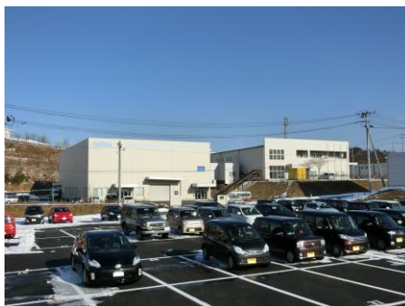
駐車場を増設しました
